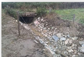
Restauration du lit mineur – affluent de la Verzée à Soudan
