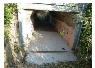
Site de stockage de la Gauteraie à Brain sur Longuenée : rejointement des murs du perthuis
